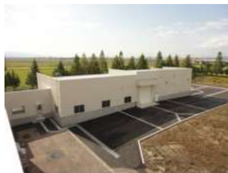
▲増築したコーティング棟
