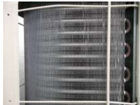
▲清掃後のエアコンフィン
